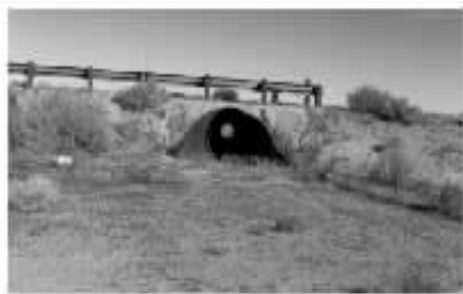
图 4 加利福尼亚 58#公路为沙漠龟设计的涵洞 Fig. 4 Pipe culvert for desert tortoise on Highway 58 in California
