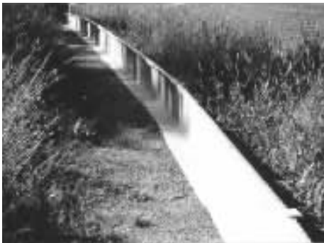
图 1 欧洲地区为小型爬行动物和两栖动物设置的电镀金属围栏 Fig. 1 Galvanized steel barrier with lip used for reptiles and amphibians in Europe
